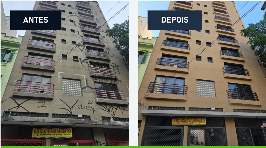
PROJETO 01 ▪ TRATAMENTO, PINTURA E REVITALIZAÇÃO
