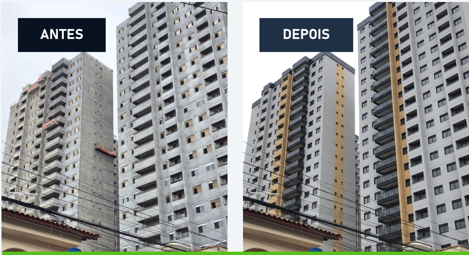
PROJETO 02 ▪ RECUPERAÇÃO E PINTURA DE FACHADA
